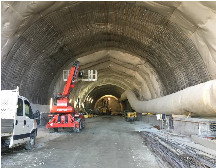
FAZA 7 Instalowanie wodoszczelnej membrany w sztrocie i kalocie.
