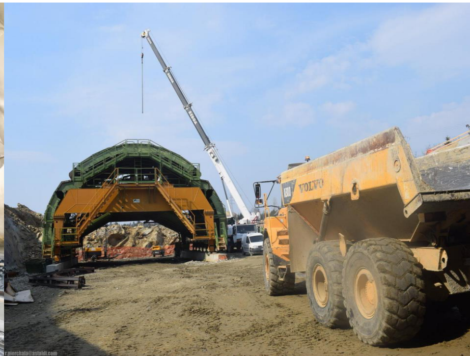
FAZA 8 Zakładanie obudowy ostatecznej w sztrocie i kalocie – układanie mieszanki betonowej.
