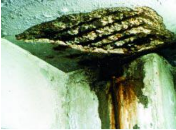
Rys. 1. Korozja stali zbrojeniowej jest najczęstszą przyczyną degradacji betonu.
