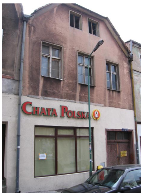
Rys. 1. Koźuchów ul. 1 Maja 7, elewacja północna
