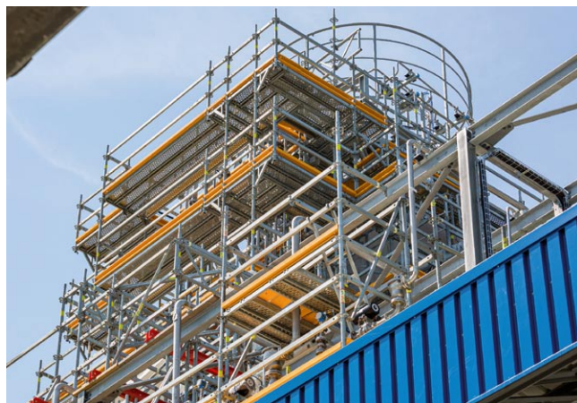
Rys. 5. Podstawowa siatka metrycznego zestawu rusztowań PERI UP zapewniła wysoki poziom geometrycznej i konstrukcyjnej możliwości dopasowania, a tym samym wysoki stopień bezpieczeństwa prac
