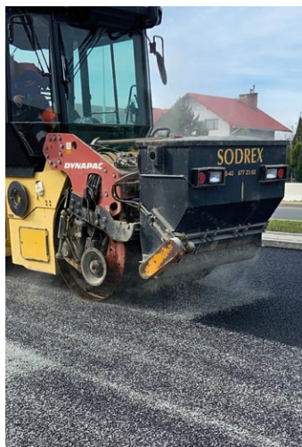
Zastosowanie asfaltu wyskomodyfikowanego MODBIT 45/80-80 do budowy długowiecznej nawierzchni na Obwodnicy Krosna.
