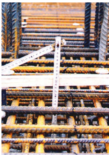
Rys. 12. Zbrojenie układane na prefabrykację stropu w rejonie słupa bez podciągów (przykład w budynku F) [5]
