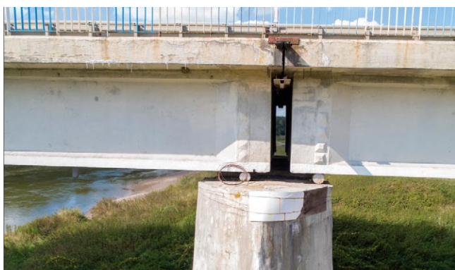
Rys. 2. Widok z powietrza na elementy podparcia przęseł mostowych na podporach
