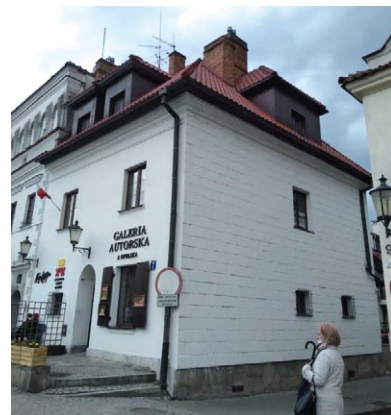
Rys. 4. Ocieplenie zewnętrzne na ścianie bocznej zabytkowej kamienicy w Kazimierzu Dolnym nad Wisłą (fot. M. Rogalska)
