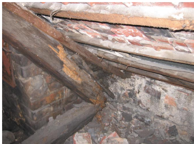
Rys. 7. Zawilgocona ścianka kolankowa; końcówki krokwi skorodowane, brak przypustnic, ugięte łąty pod dachówką
