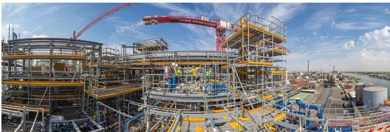
Rys. 2. W szczytowym momencie codziennie montowano do 1300 ton sprzętu PERI
