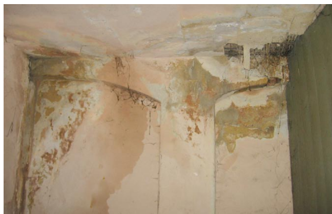
Rys. 4. Fragment ściany wschodniej na piętrze; silne zawilgocenie ściany i stropu z powodu nieuszczelnności kosza
