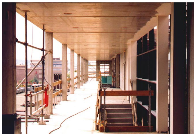
Rys. 13. Strop prefabrykowany w 6-kondygnacyjnym łączniku budynków E-H [5]
